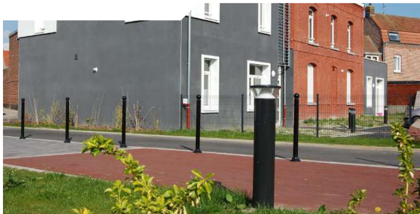
BORNE LED ADELIE, ZONE PIÉTONNE AUTOUR DE L'ÉGILSE ET DE L'ÉCOLE MATERNELLE DU CENTRE
