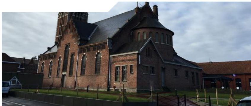
L'ARRIÈRE DE L'ÉGLISE VALORISÉE PAR L'AMÉNAGEMENT DE LA VOIE PIÉTONNE
